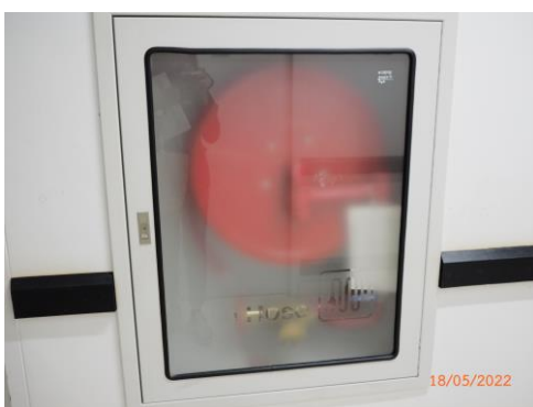
รูปที่ 2-55 เก็บบายฉีดน้ำดับเพลิงพร้อมอุปกรณ์ (Fire Hose Cabinet : FHC) ไว้ในอาคาร
