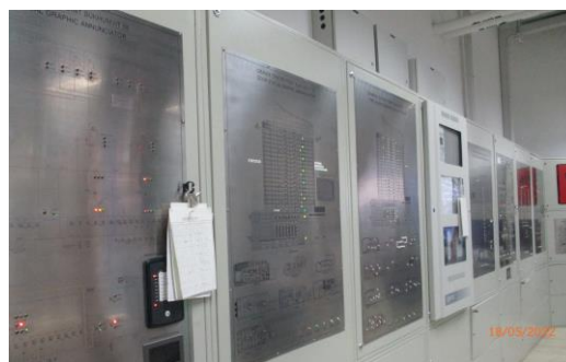
รูปที่ 2-58 แผงควบคุม เพื่อทำหน้าที่เป็นจุดศูนย์รวม การรับ-ส่งสัญญาณตรวจรับ
