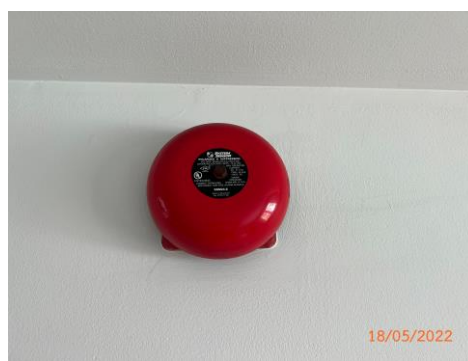
รูปที่ 2-62 กริ่งสัญญาณเตือนภัย (Alarm Bell)
