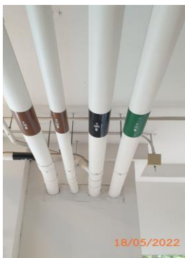
รูปที่ 2-36 ท่อรวบรวมน้ำเสียจากห้องพักรวมหลายห้อง
