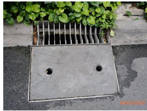
รูปที่ 2-71 ตะแกรงครอบตามรูท่อระบายน้ำทั้งภายใน และภายนอกอาคาร
