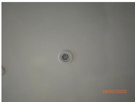
รูปที่ 2-59 เครื่องตรวจจับควัน (Smoke Detector)
