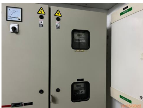
รูปที่ 2-15 ระบบมิเตอร์ไฟฟ้าสำหรับระบบบำบัดน้ำเสีย
